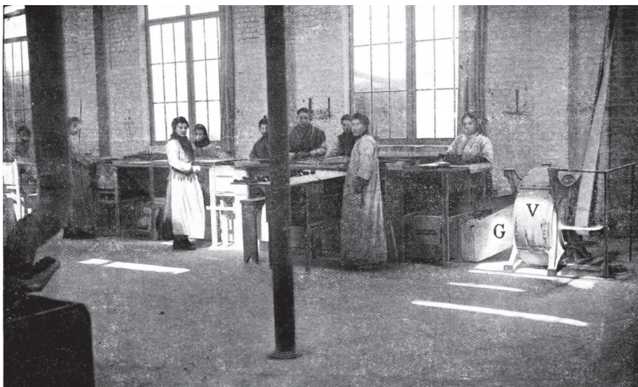
Installation hygiénique d'un atelier de vulcanisation du caoutchouc par le sulfure de carbone. Rapport annuel de l'Inspection du travail, 1900, Bruxelles, 1901, p. 237-243.
