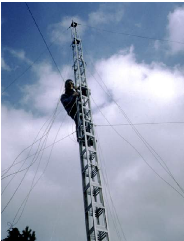
Installation du mât. (CARHOP Fonds T. Couvreur)
