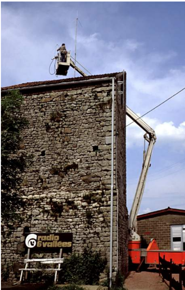
Installation d'antenne relais sur le studio de la tour « Griffons » par les pompiers de Wavre. (CARHOP Fonds T. Couvreur)
