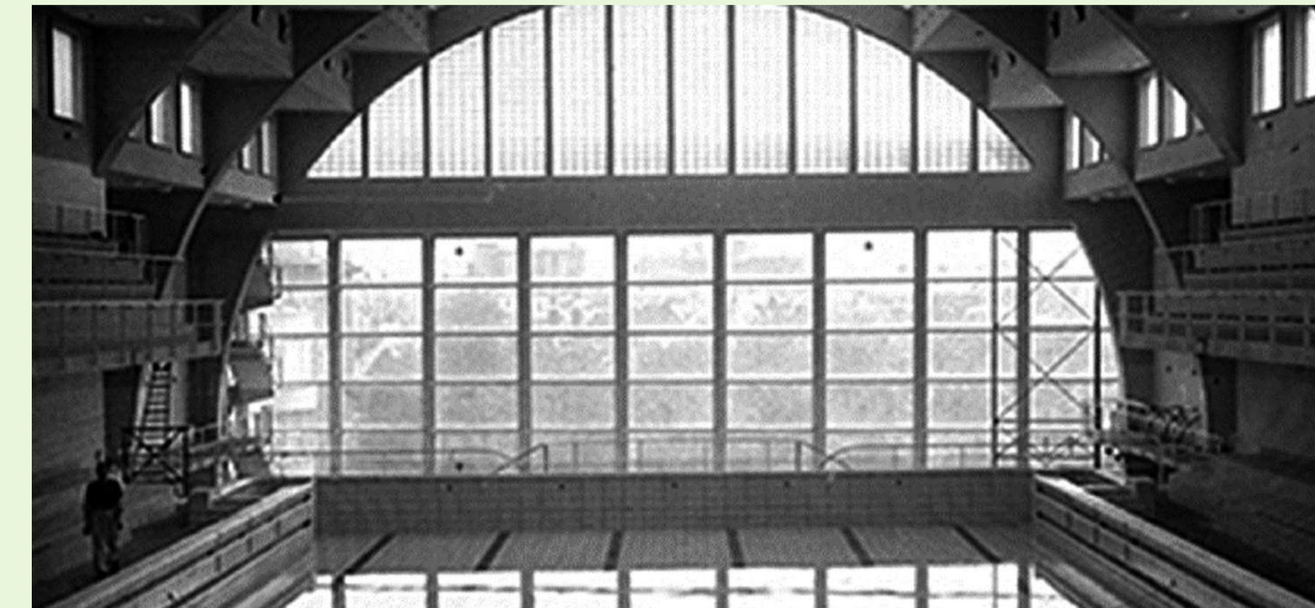
Bâtiment des Bains et Thermes (ancêtre de la Cité miroir), Liège, 1942 (site internet de la Cité miroir).
